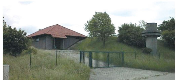
Hochbehälter in Riexing
