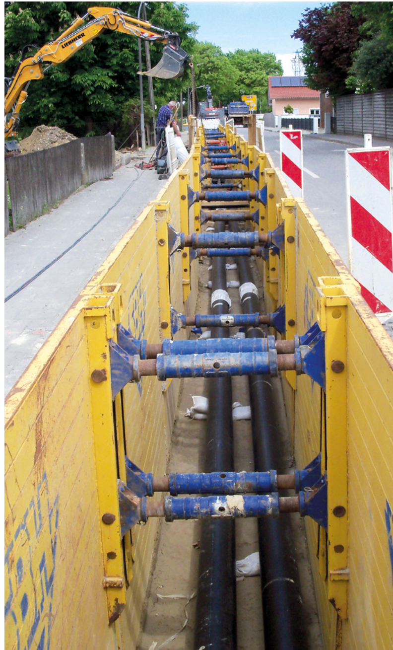
Leitungsverlegung in Oberding
