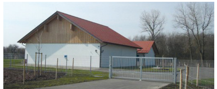
Wasserwerk 2, Hallbergmooser Str. 55, Oberdingermoos
