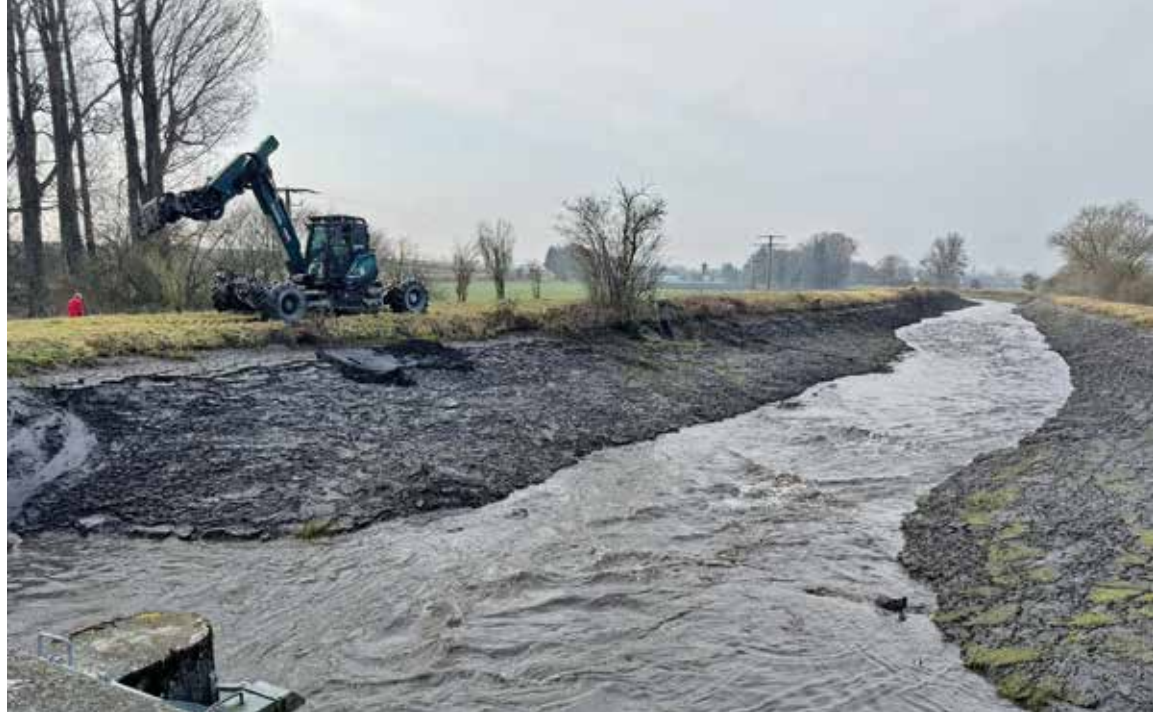
Mit einer groß angelegten Reinigungs- und Renaturierungsaktion sorgten die Fliegenfischerfreunde der Dorfen e.V. dafür, dass der Bach von der jahrzehntelangen Verschlammung des Grundes befreit wurde
